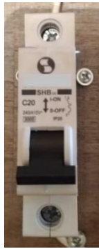
Figura 22 - Disjuntor do contator utilizado no projeto.
